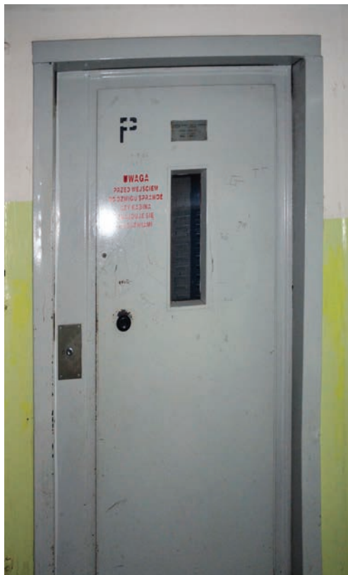
Fot. 1. Drzwi sztywne starszego typu – wychylane ręcznie, uciążliwe z powodu trzaskania, z zamkiem bezpieczeństwa bez odpowiedniej kontroli zaryglowania (możliwość odesłania kabiny na inne piętro przy niezamkniętych drzwiach), co może prowadzić do niebezpiecznych wypadków
