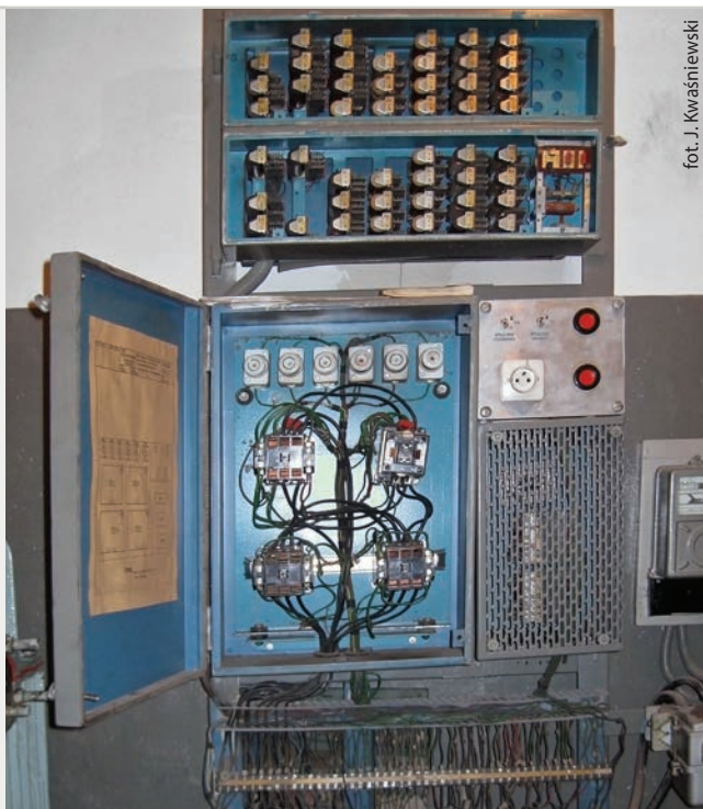
Fot. 3. Tablica sterowa (pracująca przez 38 lat) realizująca algorytm zbiorczości jednokierunkowej dla dźwigu z 11 przystankami; ze względu na niespełnienie współczesnych norm bezpieczeństwa winda wymaga pilnej modernizacji
